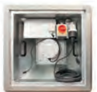
Ansicht von hinten
